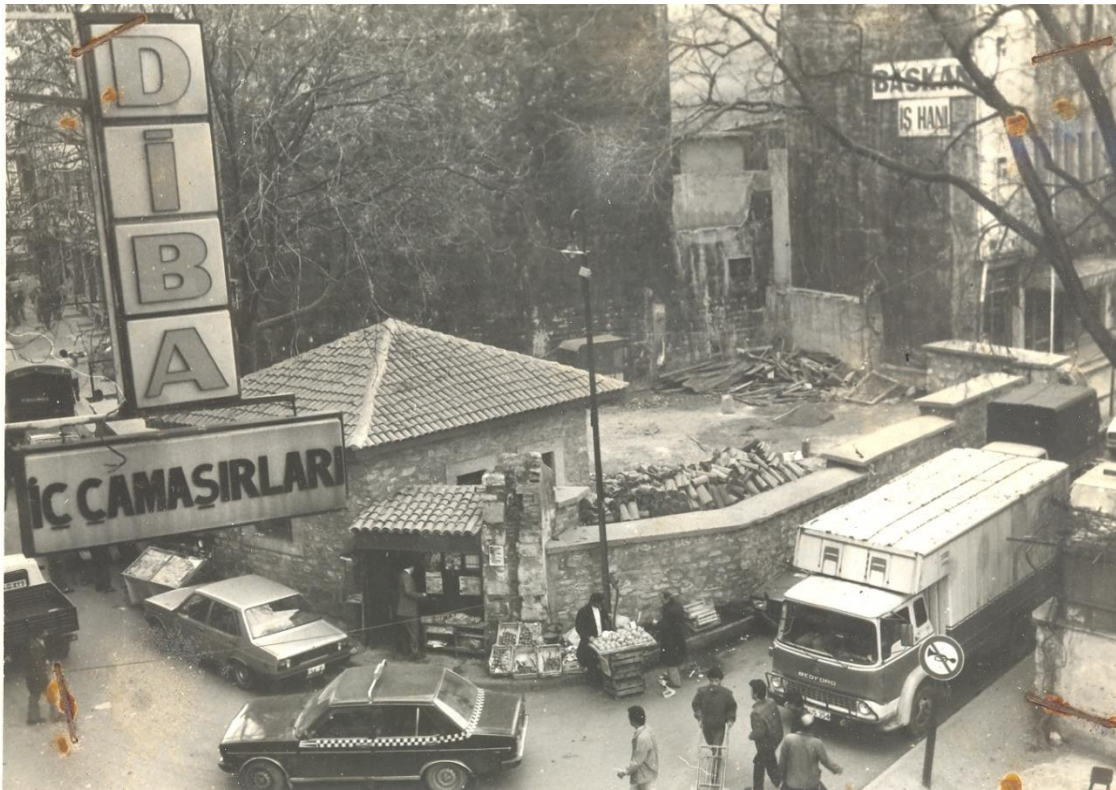
Tekkenin yıkımı sonrası yeni inşa edilen türbenin genel görünümü (İBB Arşivi)
