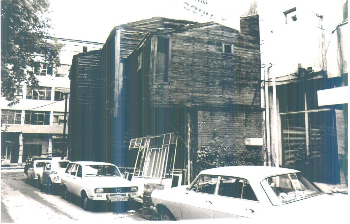
1970’lerde tekkenin güney cephesi (İBB Arşivi)
