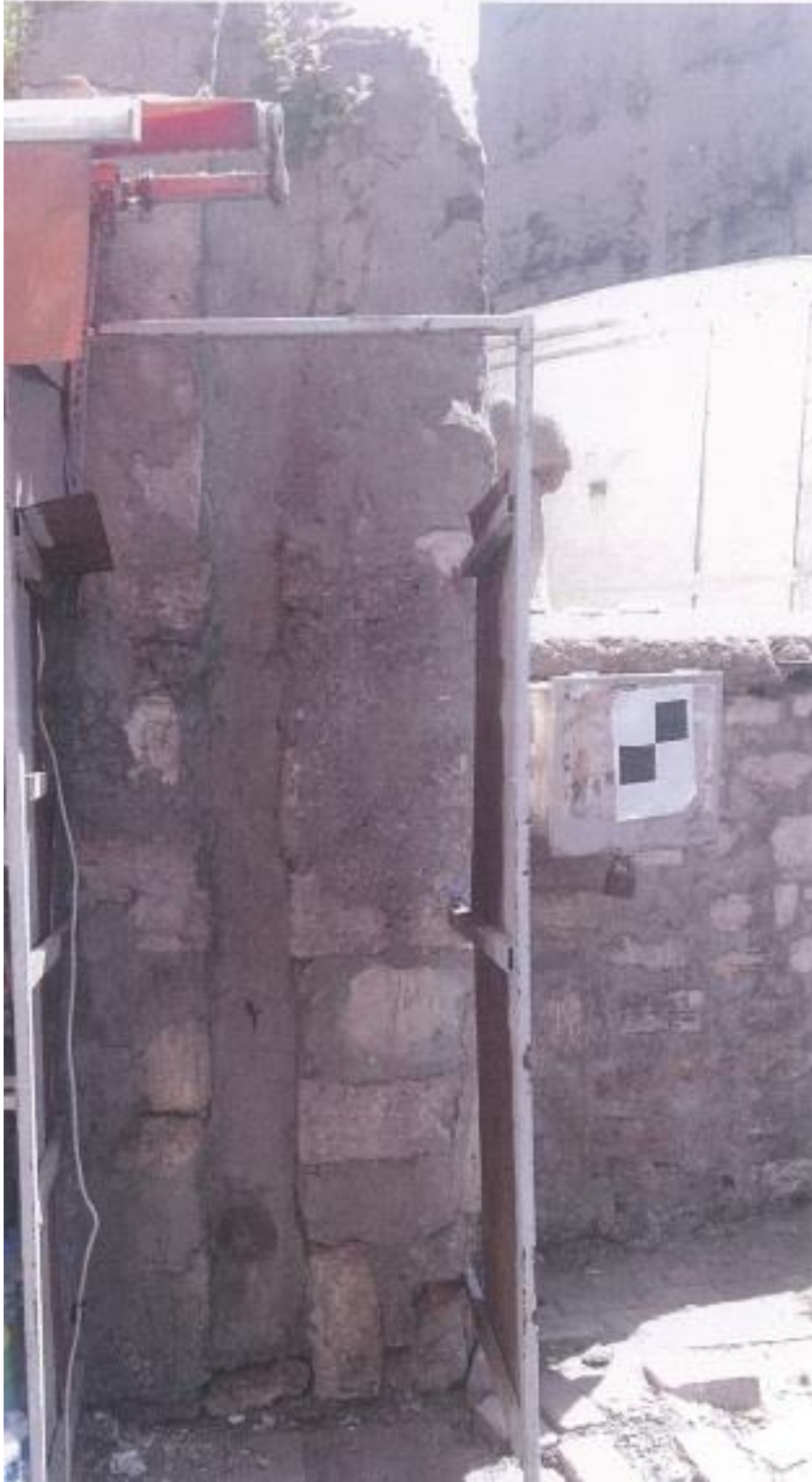
2018 yılında su terazisinin cepheden görünümü (Rölöve, Restitüsyon, Restorasyon Projeleri Raporu)
