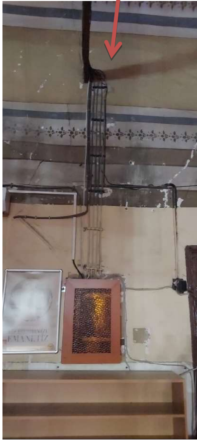
Özgün bezeme üzerinde elektrik tesisatı
