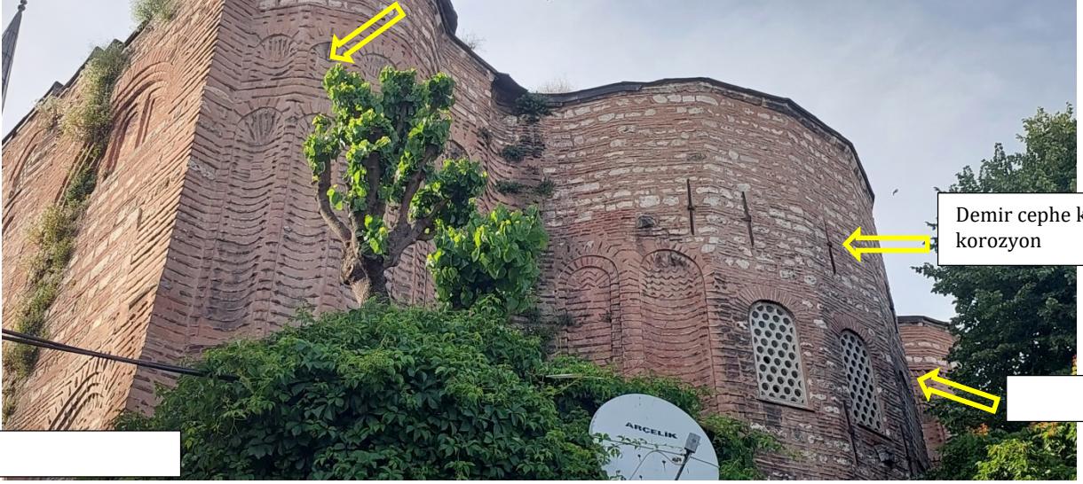
Çimento esaslı niteliksiz horasan taklidi derzler
