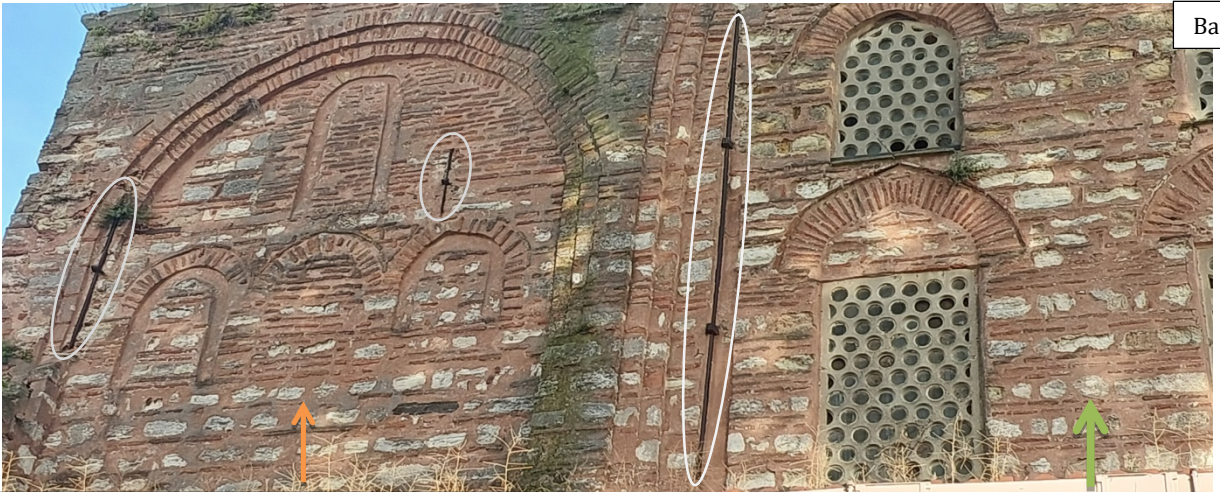
Osmanlı döneminde kapatılan Bizans dönemi pencere düzenlemesi
