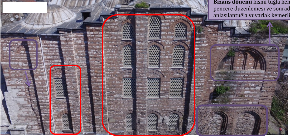
Osmanlı dönemi düzenlenen güney cephe ve saçak altı kademeli biten cephe, payeler, sivri kemerli cephe pencereleri
