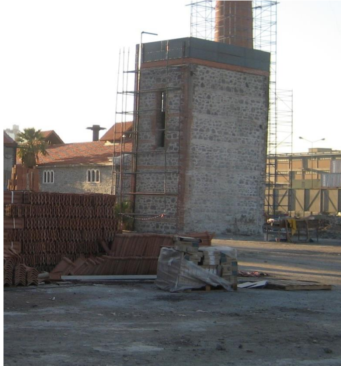
Uygulama öncesi su deposu
