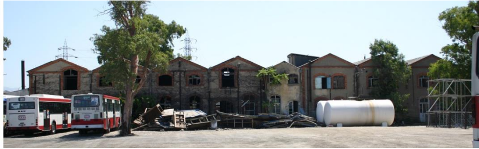
2006-2007 yılları batı cephesi
