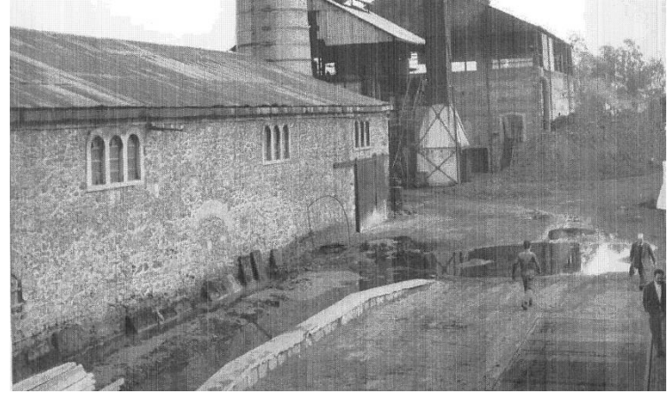
1940' lı yıllar dökümhane binası
